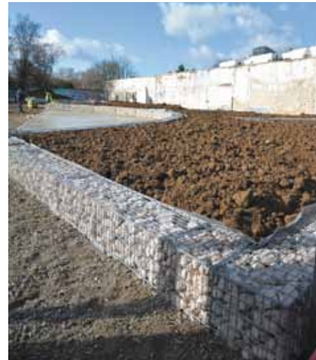
La friche jouxtant le collège Jean-Lolive se transforme en un parc de 3 000 m 2 .
