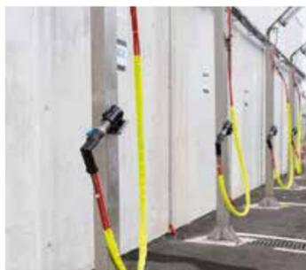
Une station de charge lente destinée aux bus non articulés roulant au biométhane.
