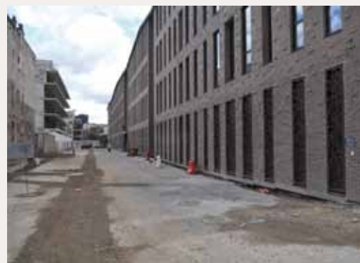
Vue de la façade depuis la rue Sainte-Marguerite où un passage permettra d'accéder à l'Intermarché et aux futurs bâtiments de deux étages dotés de jardinets, situés en cœur d'îlot.
